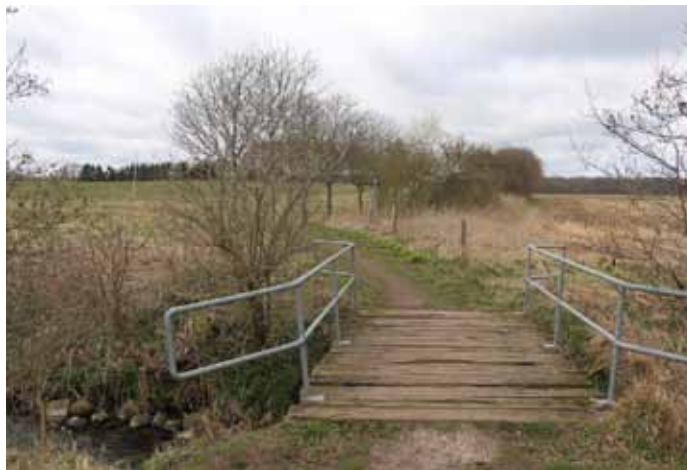
Broovergangen mod det åbne land øst for lokalplanområdet.
