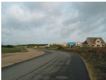
Billeder fra området. På modstående side området set fra vest. På denne side fra venstre set fra det nuværende byskilt ved den nordvestlige indkørsel til Ryomgård og et tidligt stadie af det nu næsten udbyggede område indenfor Lokalplan nr. 97.
