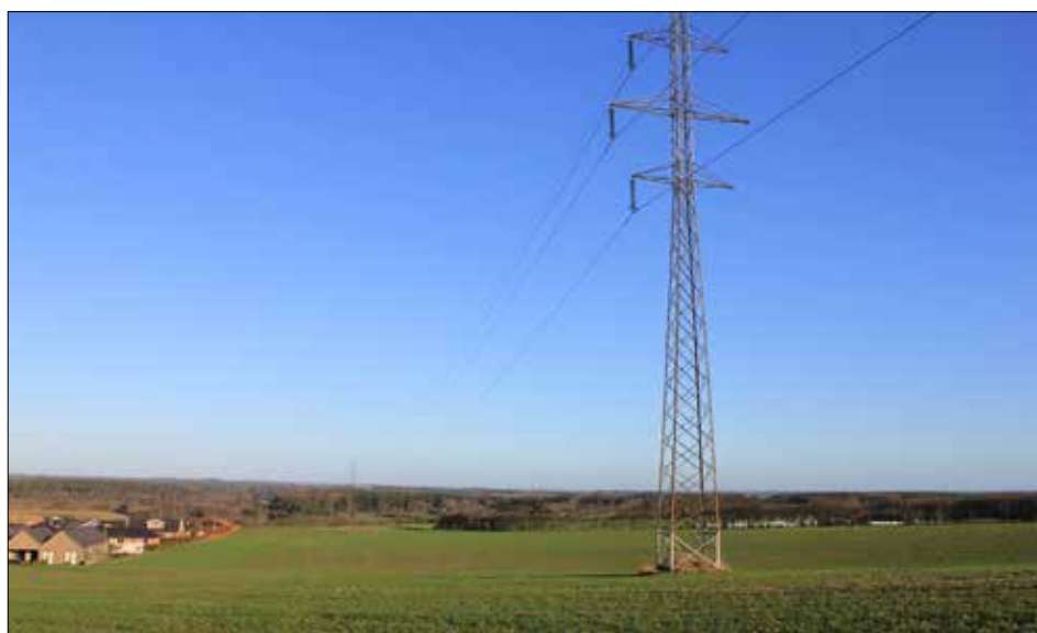
Projektområdets grænser op til et højspændingsanlæg
